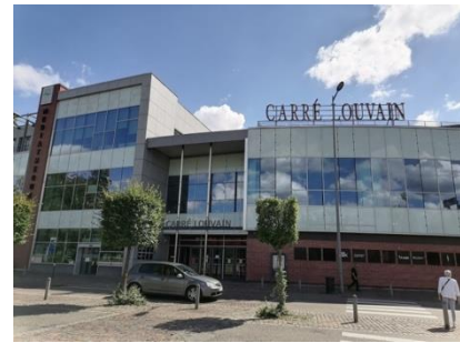
Entrée côté avenue Général Leclerc
